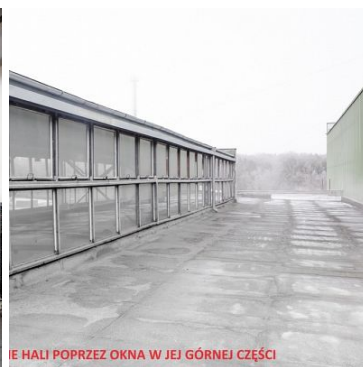
IE HALI POPRZEC OKNA W JEJ GÓRNEJ CZĘŚCI
