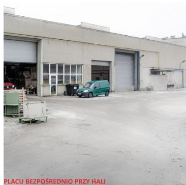
PLACU BEZPOŚREDNIO PRZY HALI
